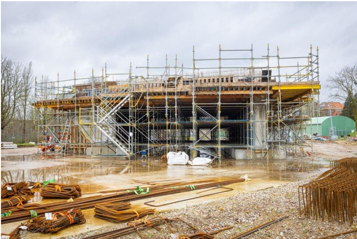
15 Realisatie een van de segmenten van de Westtunnel op de voorbouwlocatie, foto: Stefan Verkerk
