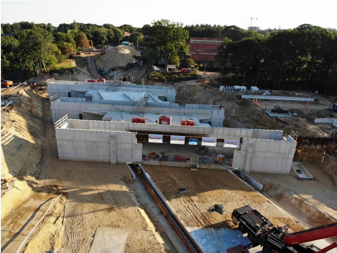
1 Tunnel is als een geheel, dus inclusief stijpunten, ingeschoven, foto: Laurens Schrama
